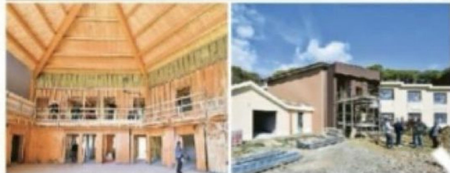
Sopra, i ragazzi del liceo artistico, sotto due immagini del cantiere (1/2) (3/4)
